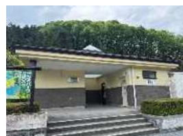
道の駅薬師の湯公衆トイレ
