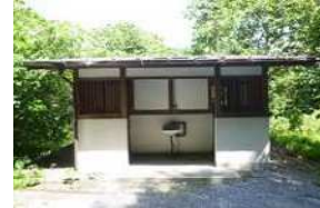
大胡桃公衆便所（解体予定）
