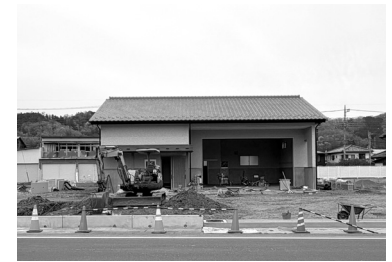
完成間近の第1支団第7分団詰所
