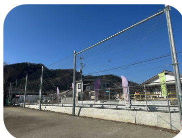
(防球ネット設置工事)
