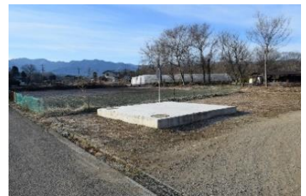
長若地内に建設した防火水槽
