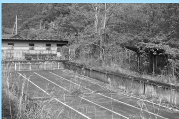
旧倉尾小学校プール
