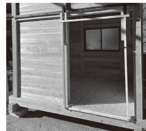
屋根、床、窓の作業が終わり、引き戸製作の準備をしている状態の写真。
