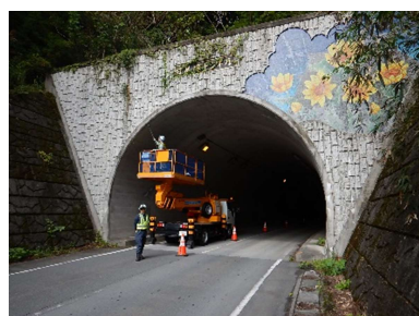
〔近接目視点検状況例〕
