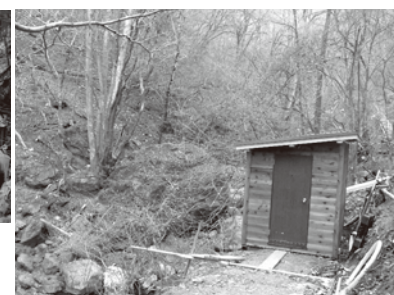
小水力発電設備
