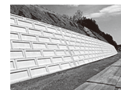
施工されたヘイベック（大型ブロック）
