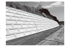
施工されたヘイベック(大型ブロック)
