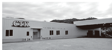
新工場 建屋全景
