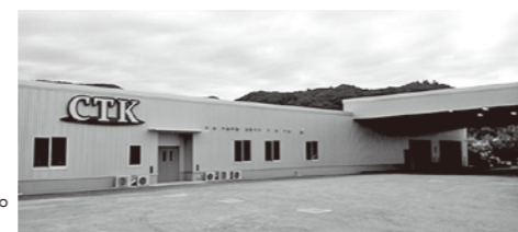
新工場 建屋全景
