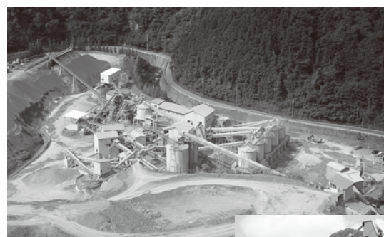
▲広大なプラント全景
