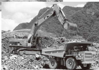
起砕された岩石は油圧ショベルにより46トンダンプカーに積込まれます。
