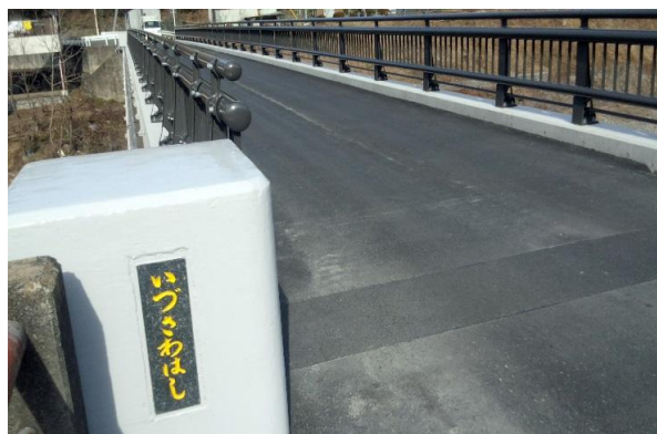
平成26年度に整備した伊豆沢橋
