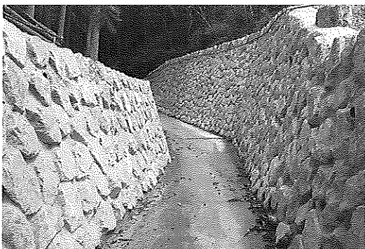
整備が進む護岸工事
