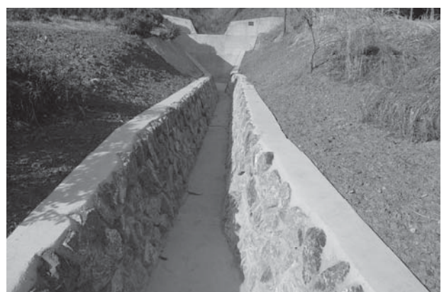
整備が進む治山工事
