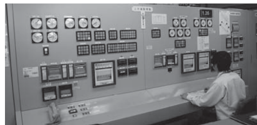
テレメーター室
