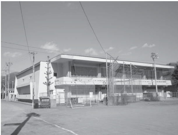
耐震補強工事を実施した町民体育館
