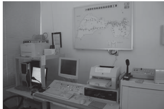
防災行政無線室
