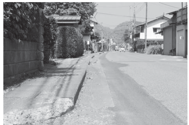
歩道段差改修工事を行う町道89号線
